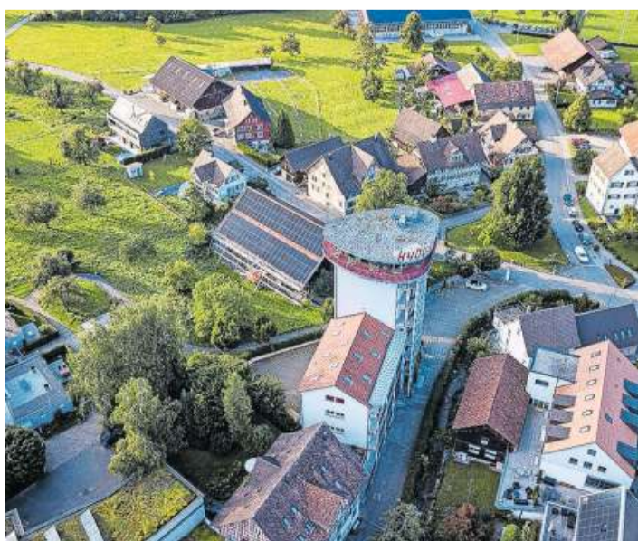
Blick von oben auf den Kybun-Tower und die Solaranlage auf dem Dach daneben.
